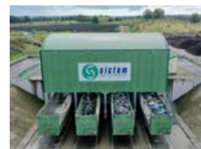
Quai de transfert 17 860 tonnes collectées en 2025 Exploitant : SRM - Domérat
