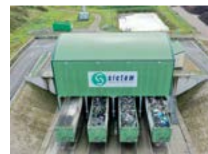
Quai de transfert 20 394 tonnes collectées en 2023 Exploitant : SRM - Domérat
