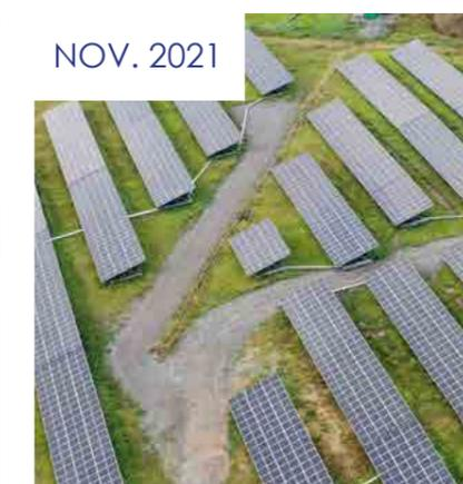
Mise en service de la centrale de panneaux photovoltaïques. 10 800 modules ont été installés sur l'ancien site d'enfouissement du SICTOM. Estimation de production annuelle en électricité : environ 4 984 MWh (l'équivalent de 3400 foyers). Construite par la société LUXEL, filiale d'EDF renouvelable, la centrale dispose d'une autorisation d'exploitation de 30 ans.
